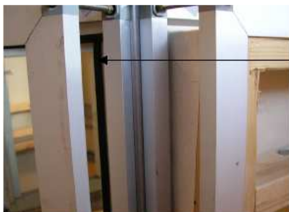
Obrázek 2. Těsnění s měkkým (dutým) pryžovým profilem
