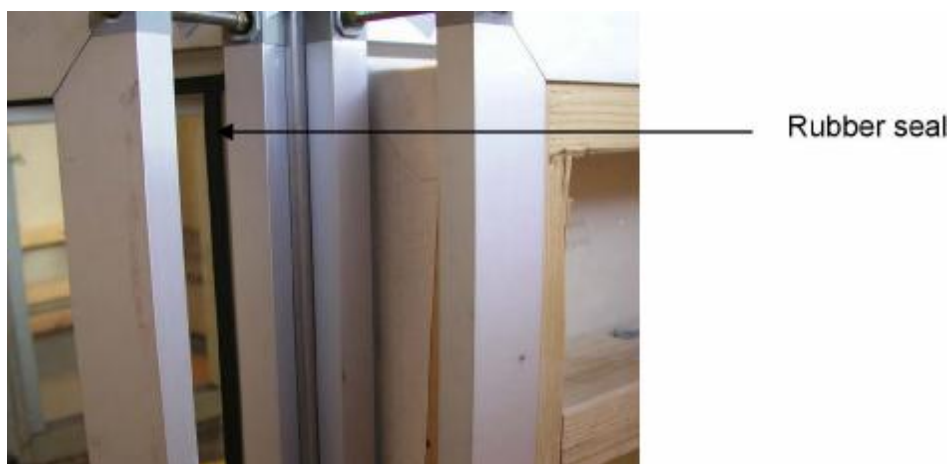
Obrázok 2. Tesnenie s mäkkým (dutým) gumeným profilom.
